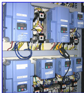
インバータ取付け事例
