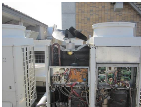
室外ファンモーター、電気品交換
