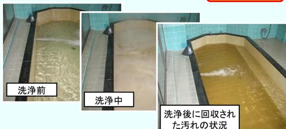
ろ過器や循環配管の内壁は生物膜が生成されやすく、レジオネラ属菌の温床となります。年1回以上は洗浄が必要となります。
