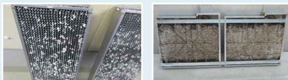
洗浄後の加湿エレメント。スケール中の特に硬質な成分が白く残留している。
